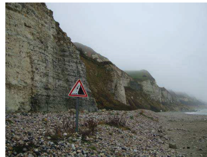
Risque d'éboulement de falaise identifié sur le littoral de la commune.
