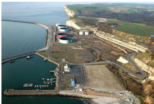
Vue sur le terminal pétrolier d'Antifer.
